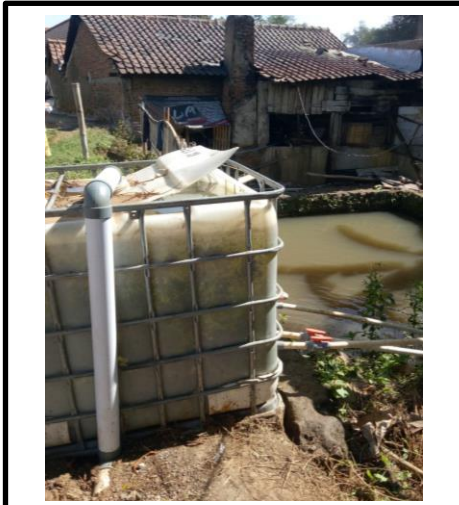
Penampungan Air Bersih Pada Pabrik Tahu Saribumi
