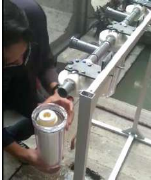
Proses Penggantian Filter UF
