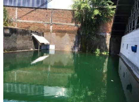
Kondisi Bak Penampung
