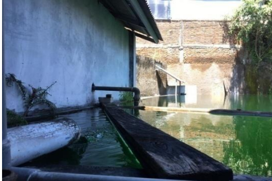
Kondisi Bak Penampung
