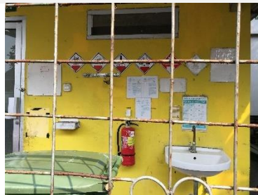
Kondisi sarana & prasarana di TPS
